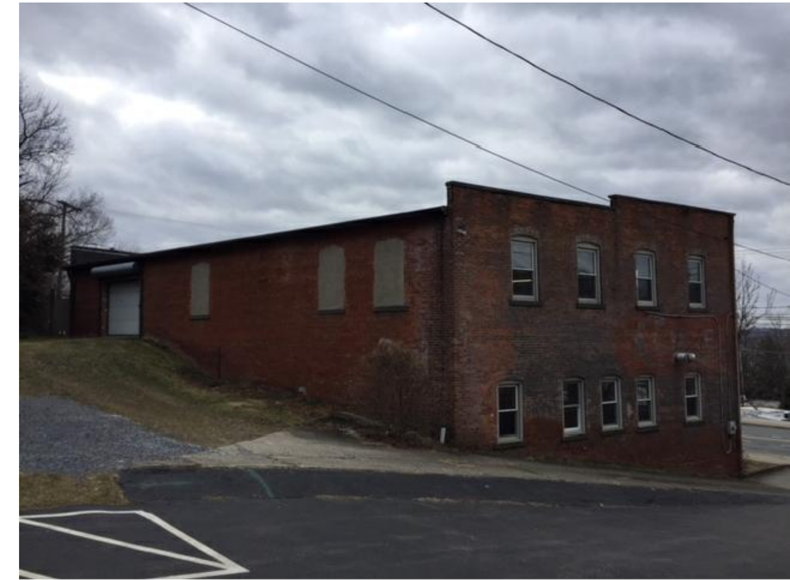
3 VIEW FROM NE (REAR) N.T.S.
